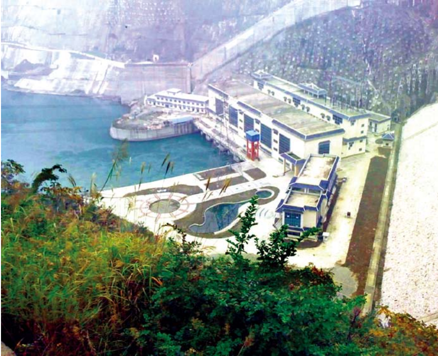
紫坪铺水电站（中国四川）
